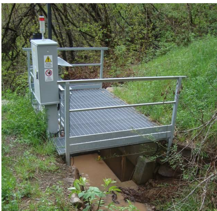
Figura 20. il sistema per l'automazione della serranda.
