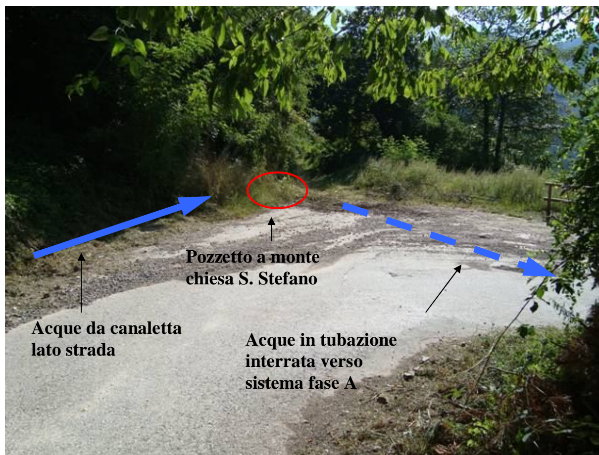
Figura 12: pozzetto a monte della chiesa di S. Stefano che permette alle acque di confluire nel sistema fase A.
