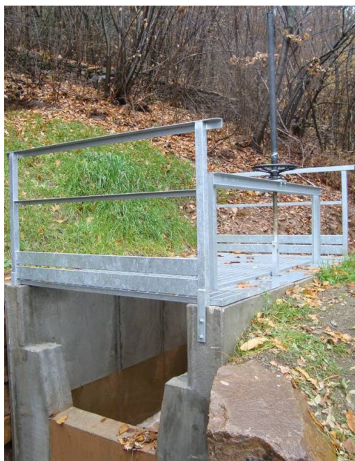
Figura 8: vasca di deviazione opere fase A munita di saracinesca.
