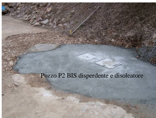
Figura 23: realizzazione del pozzo disperdente 2P bis e griglia presso l'area A.RT 3 vicino al lotto 2.
