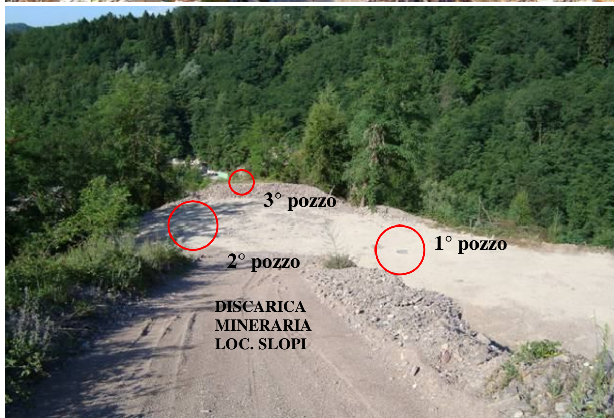
Figura 10 e Figura 11: canale di gronda prima della deviazione e ubicazione pozzettoni drenanti.
