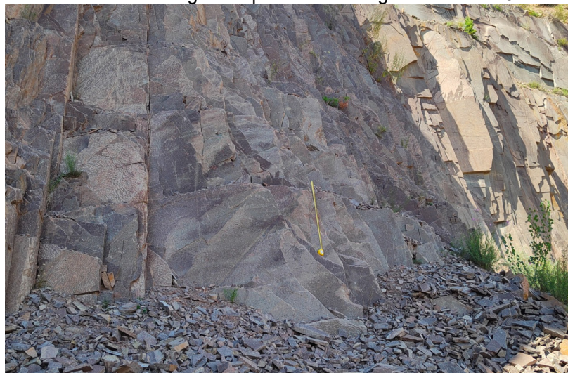
Dettaglio del punto di rilievo geomeccanico 9
