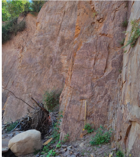
Dettaglio del punto di rilievo geomeccanico 19
