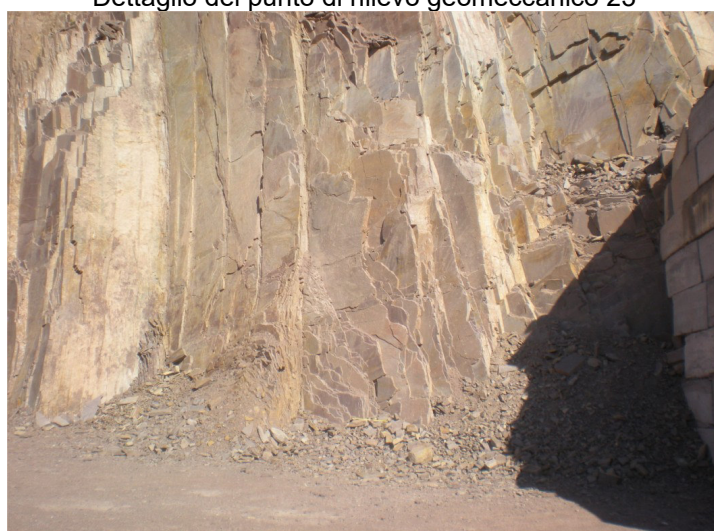
Dettaglio del punto di rilievo geomeccanico 24
