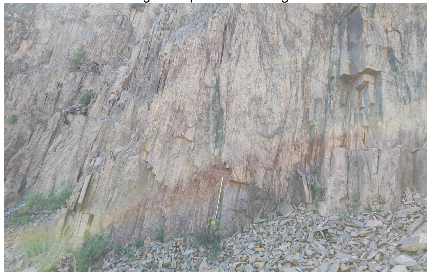
Dettaglio del punto di rilievo geomeccanico 8
