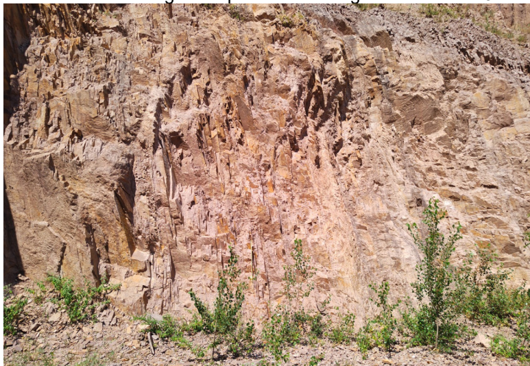
Dettaglio del punto di rilievo geomeccanico 20
