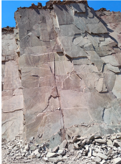
Dettaglio del punto di rilievo geomeccanico 13
