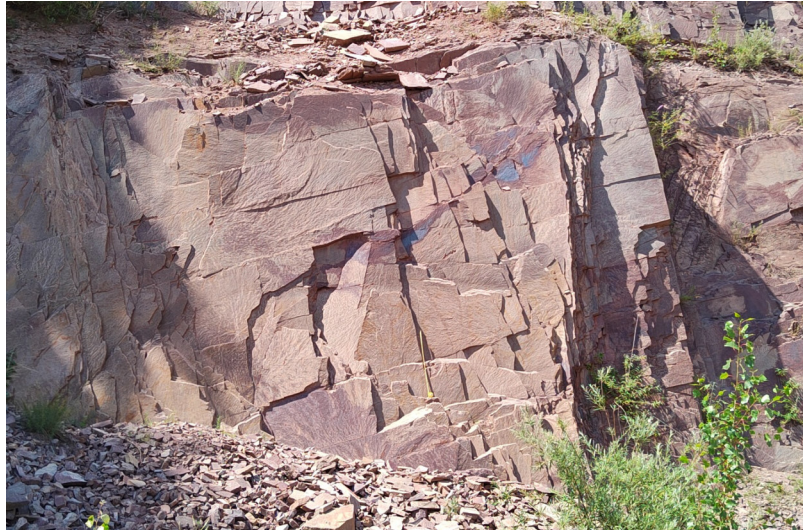
Dettaglio del punto di rilievo geomeccanico 7
