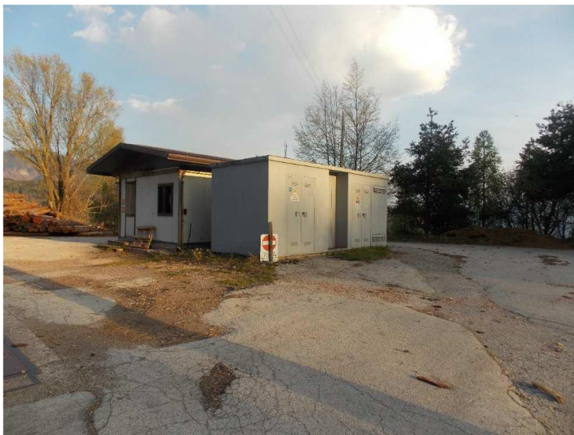
Figura 27: Cabina di media tensione attualmente presente nell'area
