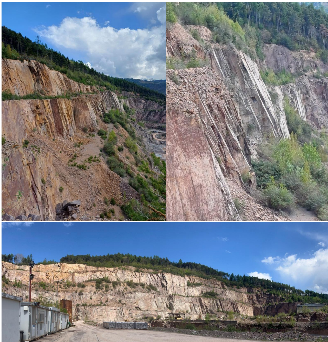
Figura 7: Fotografie dello stato attuale dei versanti dell'area estrattiva in oggetto
