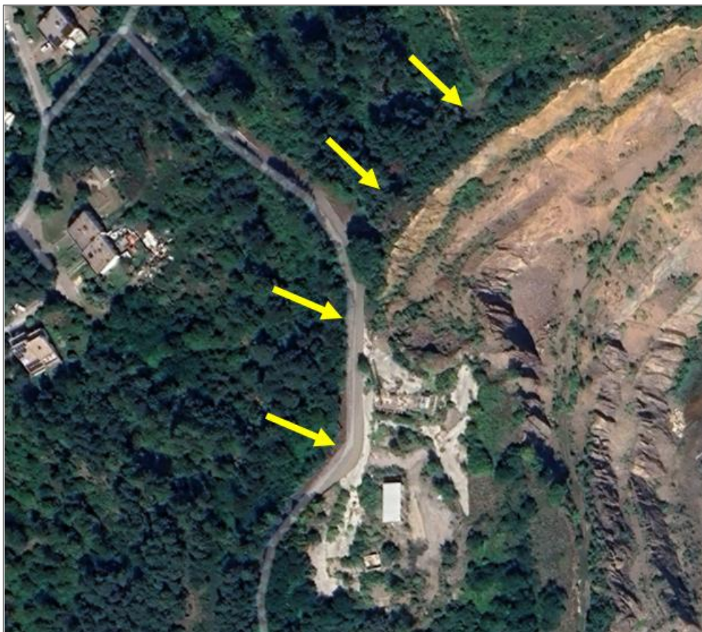
Figura 29: Indicazione del tracciato che verrà utilizzato per realizzare la viabilità a servizio dell'area di ampliamento
