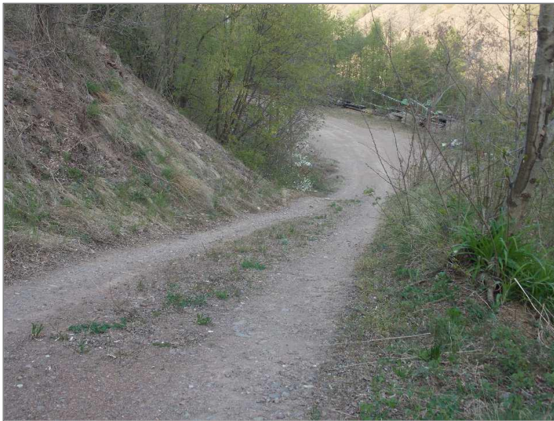
Figura 19: Attuale strada di cantiere in località Sfondroni
